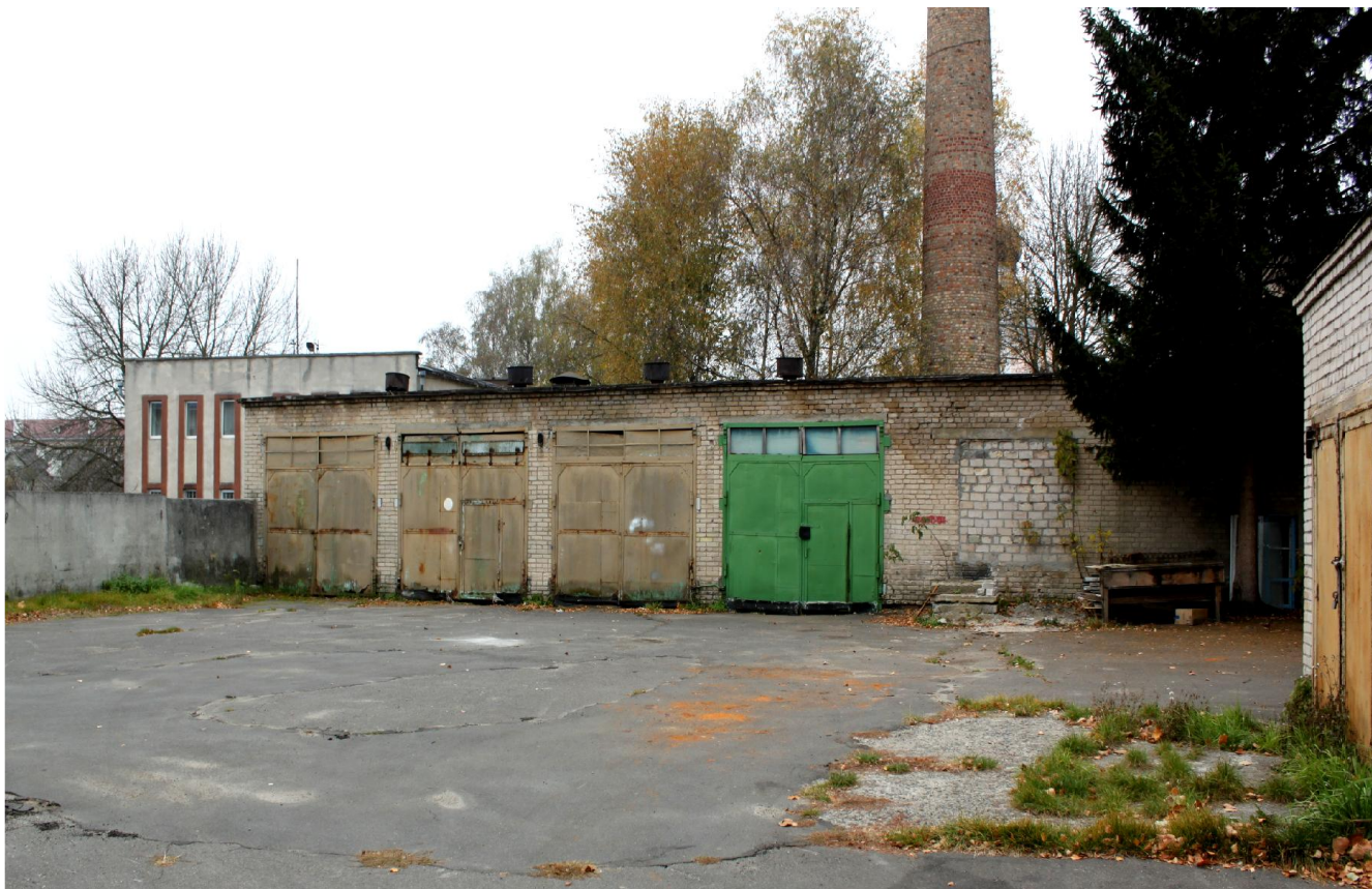
Рис. 3 Здание бывшей котельной с дымовой трубой
